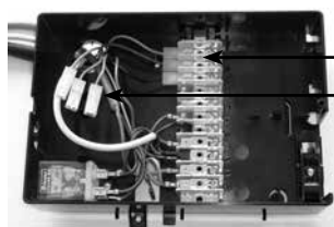
Пример разводки проводов: 5-3-1 два скорости доступны, легкий доступ
